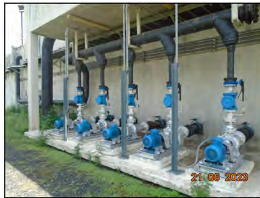
ภาพที่ 2-5 อุปกรณ์สำรองที่ใช้ในระบบบำบัดน้ำเสีย
